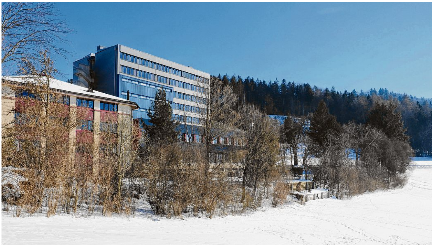
Im bisherigen Institut Guglera ist alles vorhanden, was es für ein Bundesasylzentrum braucht.
