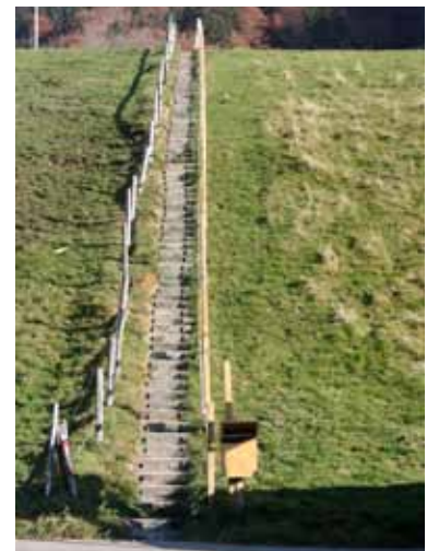
Die ersten sieben Stufen der Eichholztreppe.
