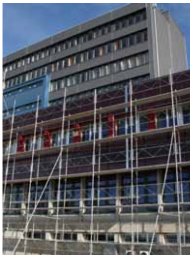
Gerüst zur Montage der Photovoltaik-Anlage.
