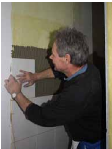
Henrick beim Plattenlegen in den Duschen und Toiletten.
