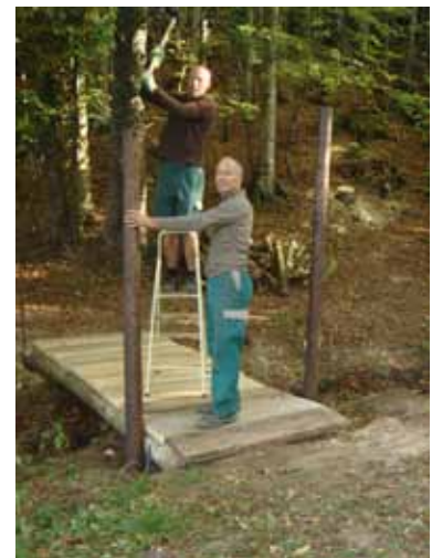
Josef und Petr beim Bau einer neuen Brücke.
